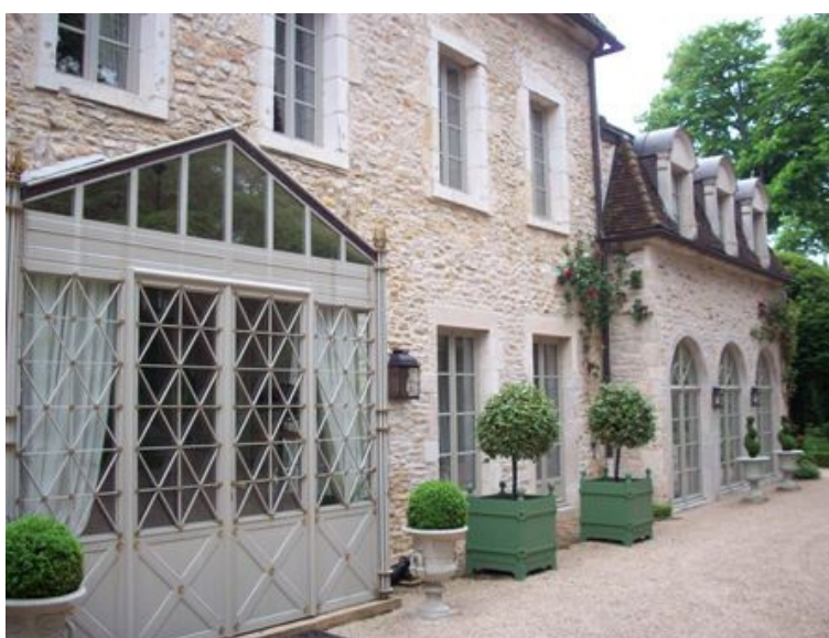
Bâtiments du domaine donnant sur le parc Joly.
